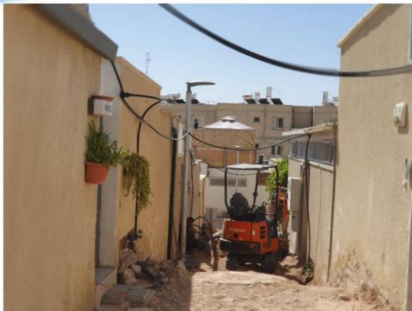
קו מים חדש באורך של כ-1000 מ' הונח, על מנת להבטיח אספקת מים אמינה לחוף הדרומי ולאפשר את פיתוח חוף קצא"א לרווחת תושבי העיר ואורחיה.
