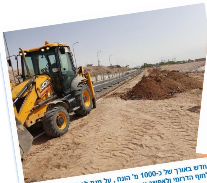
"עין נטפים" הניח קו ביוב מאסף באורך של כ-2 ק"מ ובקוטר של כ-500 מ"מ לסילוק ביוב ממתחם החירום החדש ומפרויקט הגולף. עלות העבודה כ-3,000,000 ₪.
